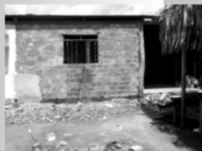
Quarto em construção
