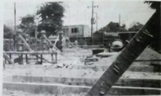
Construção: área de 300 m 2
